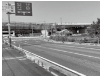
道の駅と工事が進む山陰道
