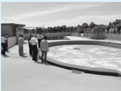
5月20日 大栄小プール老朽化の現地確認
