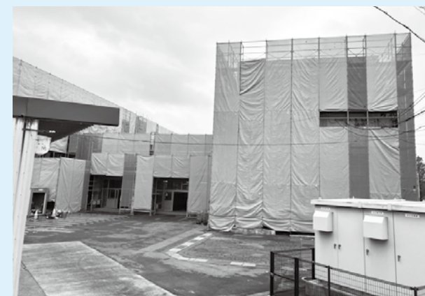
築50年、大栄小の大規模修繕
