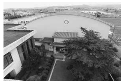
耐震工事を行う北条体育館
