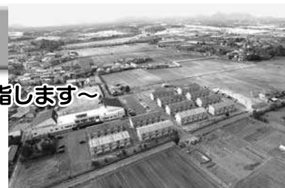
建替えを行う町営由良宿団地
