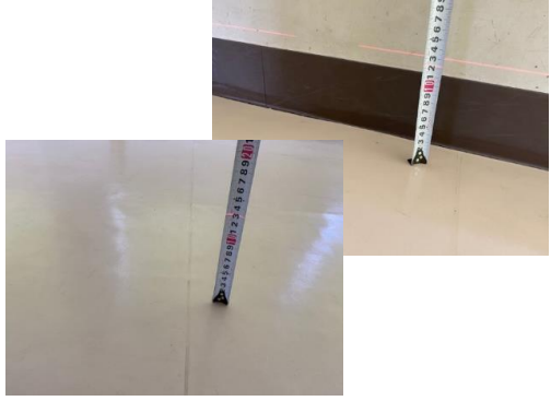
2階床/床の傾き (欠陥建築の判定)
