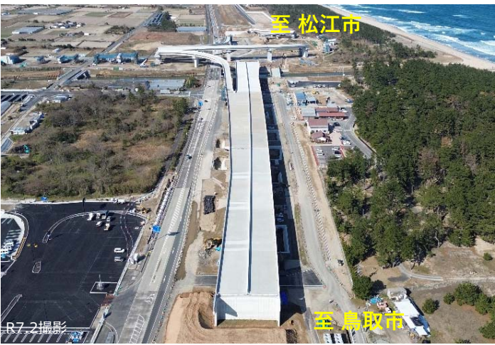
▲写真① 北条JCT (仮称) より松江市方面を望む
