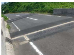
<農道舗装段差修繕状況>
