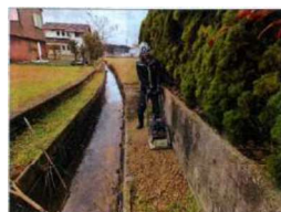
<水路陥没部修繕状況>
