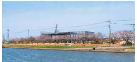
建設中の様子
