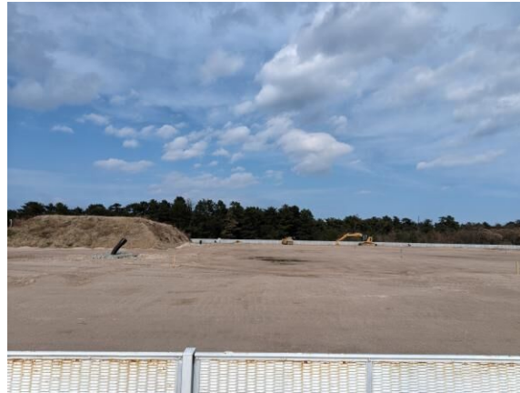
【第2工区の様子（R8.2.5撮影）】
