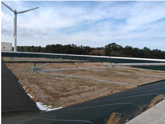
【第3工区の様子（R8.2.5撮影）】
