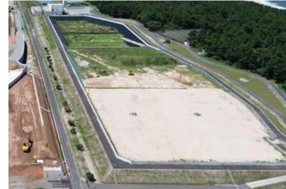
【第1工区の様子（R6.6撮影）】 キャッピング工事実施済み
