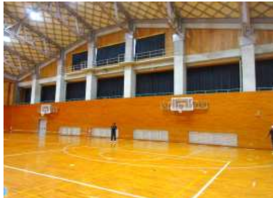
北条中学校体育館暗幕取替工事
