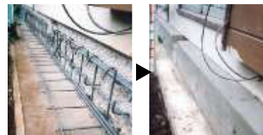
鉄筋コンクリート打増しによる基礎の補強
