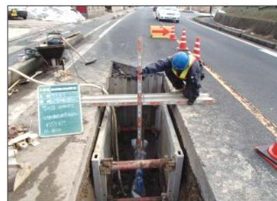
配水管新設工事 （由良宿工区）
