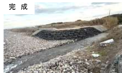
宮尻川護岸整備(大谷地区)
