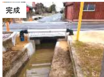
町道松神國坂線側溝改良工事 (9工区)
