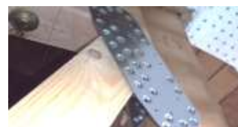
筋交い、金物による補強
