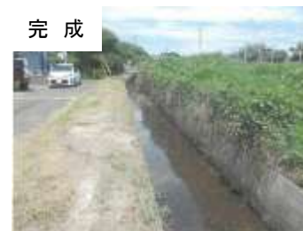
水路土砂撤去(由良宿2区地区)
