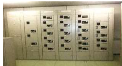
水処理コントロールセンターの更新
