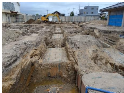
掘削作業の様子
