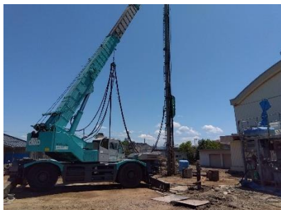
杭打ち作業の様子
