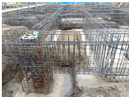
鉄筋工事の様子
