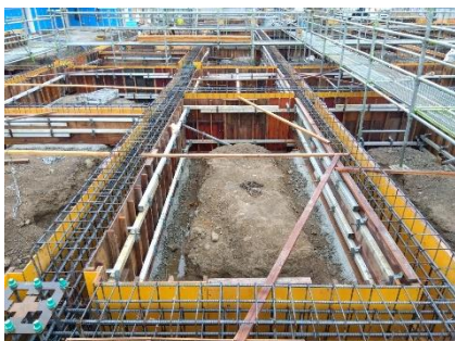
型枠工事の様子
