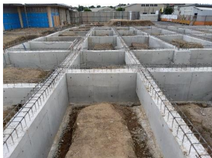
コンクリート脱枠の様子
