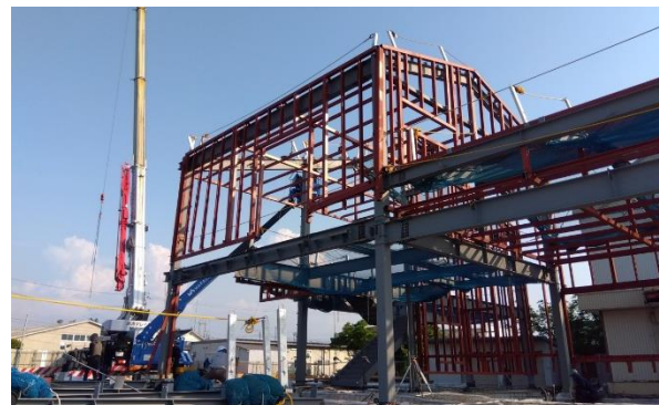
鉄骨建方(てっこつたてかた)の様子
