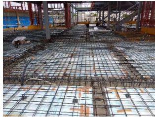
土間配筋の様子
