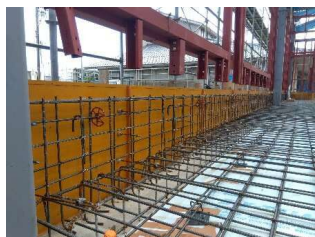
外周部型枠組みの様子
