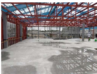
床のコンクリート打設完了
